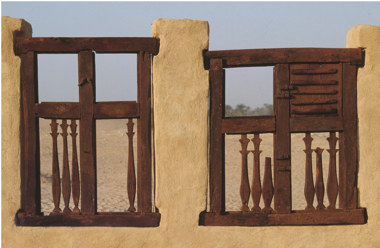
Fig. 5. Les fenêtres découvertes dans le pyrgos 2400-III, remontées (© J.-F. Gout, IFAO)
