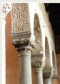
Gant. XIII e . Poutre, basilique Sainte-Euphrasie, arcades de la nef avec décor de stucs (IX e siècle).
